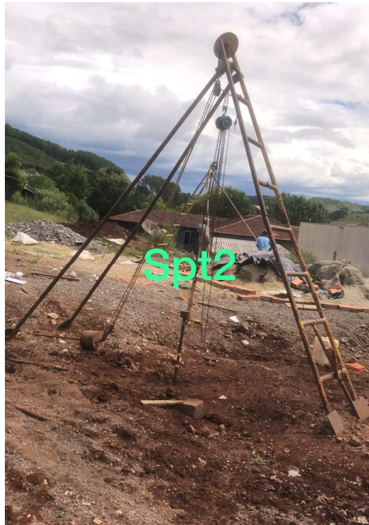
Figura 5 – Instalação do equipamento SPT-02.
