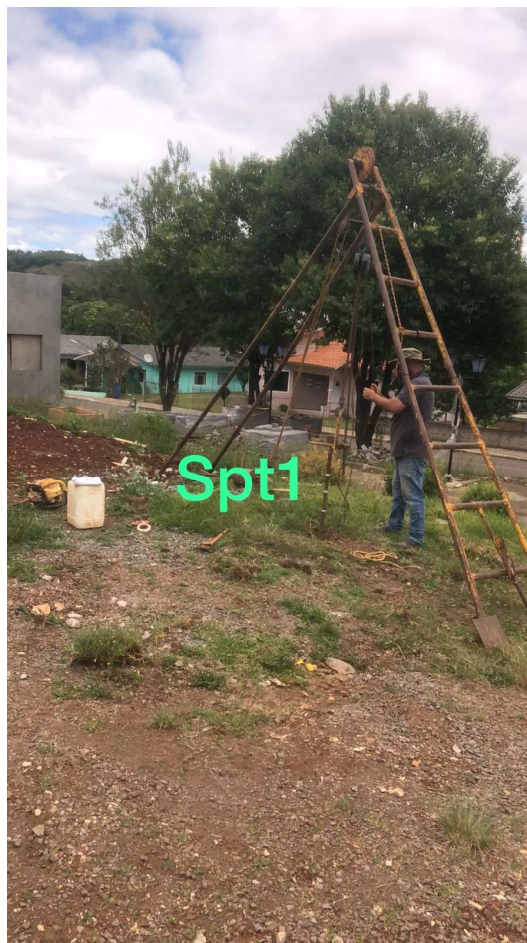
Figura 2 – Instalação do equipamento SPT-01 .
