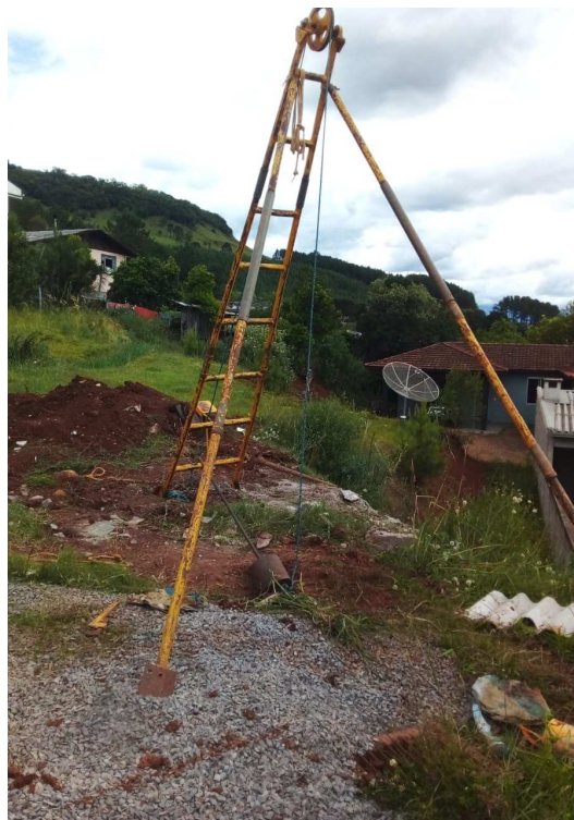
Figura 14 – Instalação do equipamento SPT-04.
