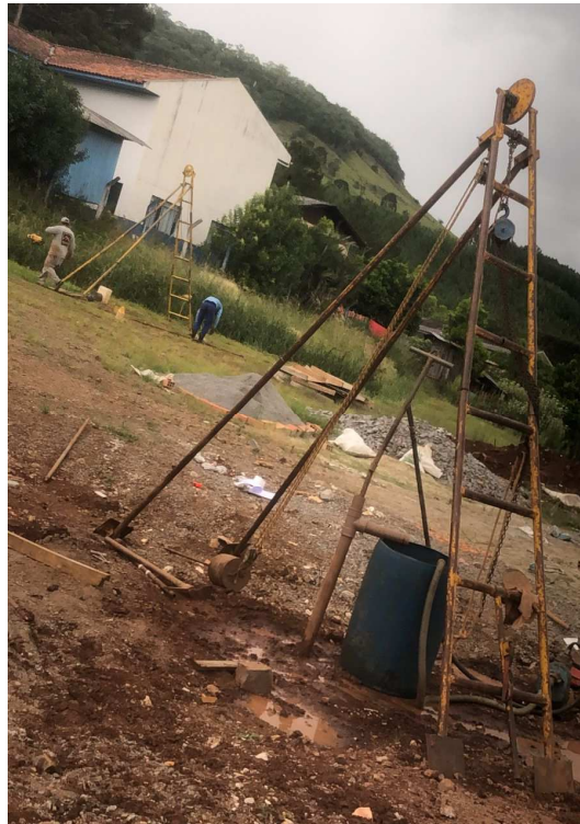
Figura 9 – Instalação do equipamento SPT-03.
